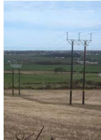
132kV wood pole
